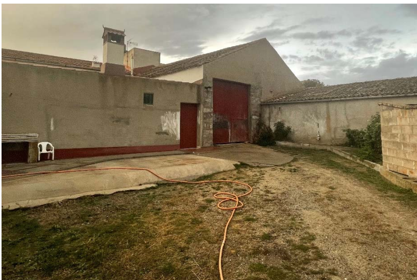
Imagen de la Edificación dentro de la parcela.
