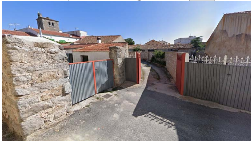
IMAGEN ACTUAL DEL ACCESO A LA PARCELA | CALLE SAN JOSE 3B
